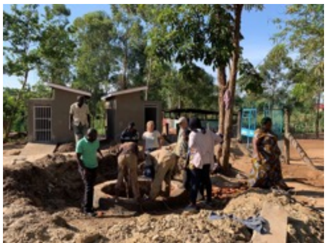
Baubesichtigung durch Bau- und Schulleitung und CM
