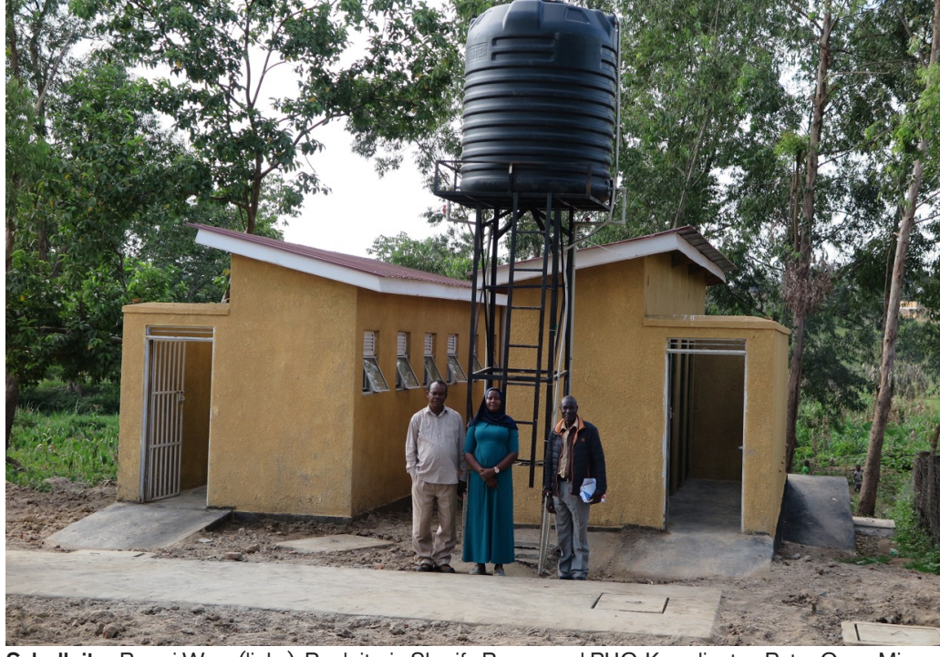
Schulleiter Perezi Were (links), Bauleiterin Sharifa Bunga und PUC-Koordinator, Peter Owor Minor, vor dem stillen Örtchen, das mit finanzieller Hilfe aus Niebüll entstand. FOTO: ROTARY CLUB
